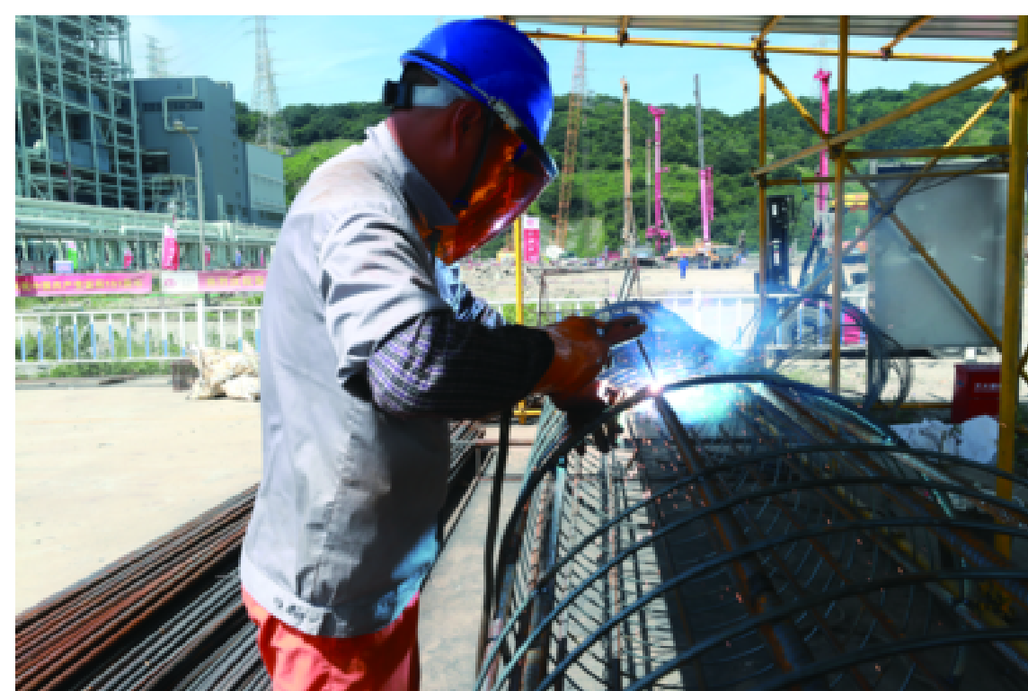
国能三期施工现场焊工接受双重炙烤
